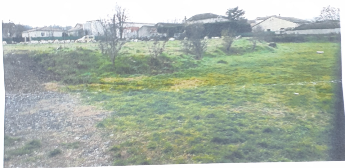
Un accès mis en forme et stabilisé
