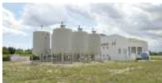
Station d'eau potable Les Baisses (30)
