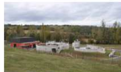
Station d'épuration de Marcillac (12)
