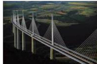
Viaduc de Millau (12)
