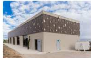
Usine de décarbonatation de Bernis (30)
