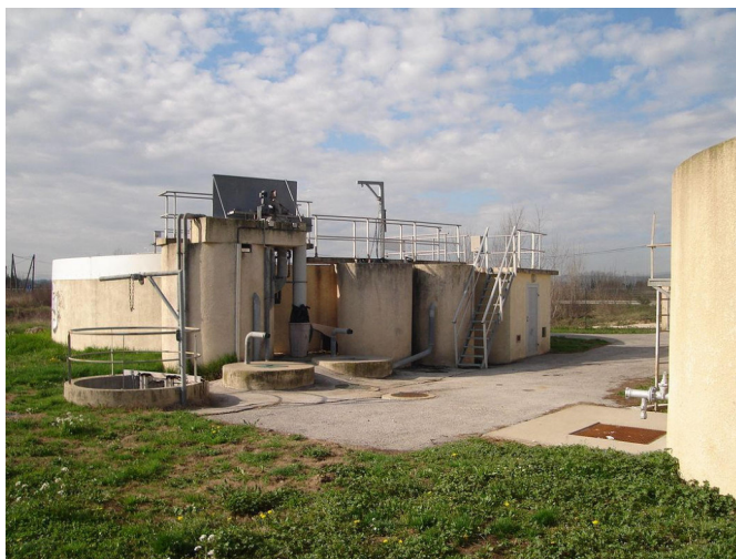
Station d'épuration de Lézan
