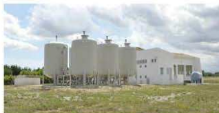
Station d'eau potable Les Baisses (30)
