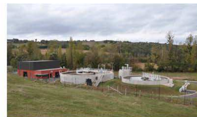
Station d'épuration de Marcillac (12)
